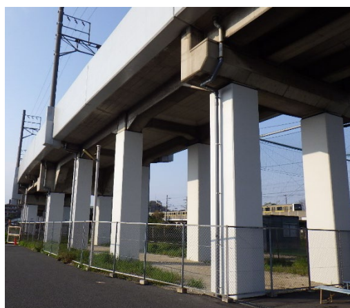
千原線高架橋着工後
