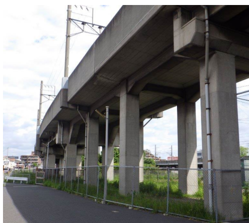
千原線高架橋着工前
