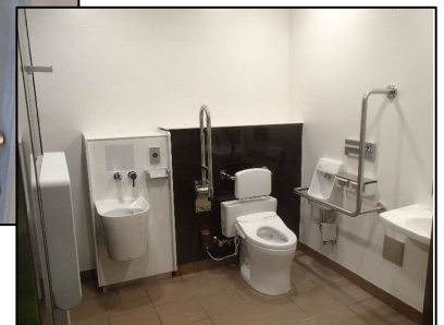
完成後の検見川駅バリアフリー施設 (左：スロープ、右：多機能トイレ)
